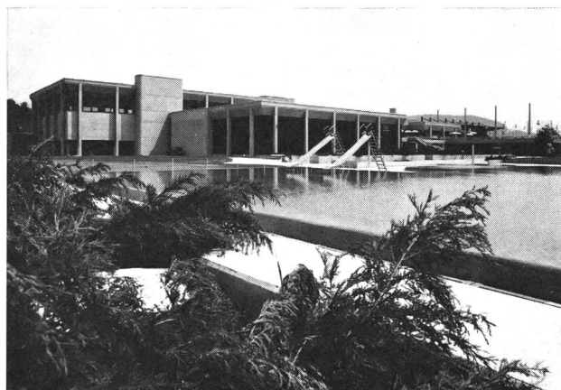
Das neue Nichtschwimmerbecken. Im Hintergrund ist das Hallenbad sichtbar, links aussen der Saalbau. Mit dem Baumanagement für die Gesamtanlage war das Generalunternehmen Ernst Göhner AG, Zürich, beauftragt.
