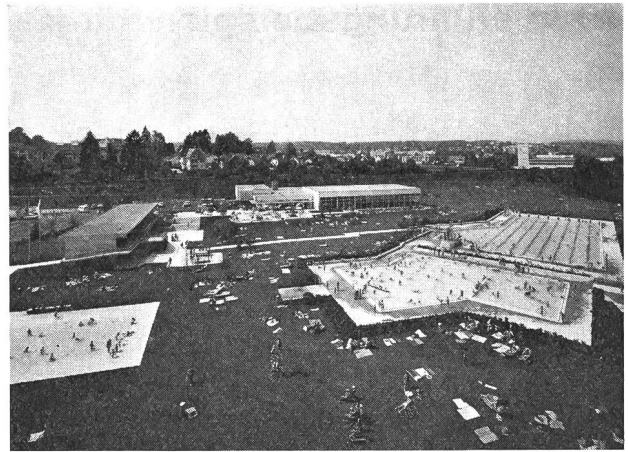
Das Luftbild zeigt die Zuordnung der Anlagenteile, links separate, leichte Sommergarderobe, links hinten die nebeneinanderliegenden, aber separierten Eingänge zu Freibad und Hallenbad.
