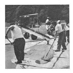
Lärchenplatz Magglingen: Einbau des Kunststoffbelages auf die verlegten Schaumstoffplatten
