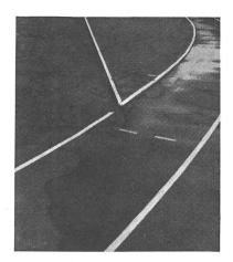
Für reine Wettkampfanlagen empfiehlt sich die Halbkreisflächen zwischen Tor und Bahnrunde gleichfalls mit Kunststoffbelag auszurüsten. Dabei kann der Wassergraben im Scheitelpunkt an die Aussenbahn angeschlossen werden.
