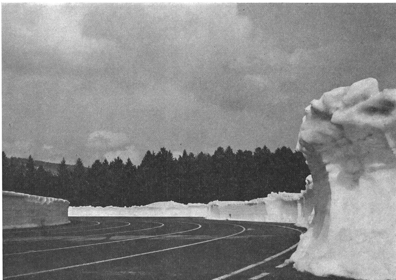
Die Winteraufnahme der 400-Meter-Tartanbahn «End der Welt» in Magglingen zeigt, wie leicht eine Kunststoffpiste schneefrei gehalten werden kann. Der letzte Rest wird von der Sonne abgetaut. Einwandfreie Funktion der Entwässerung ist Voraussetzung.
