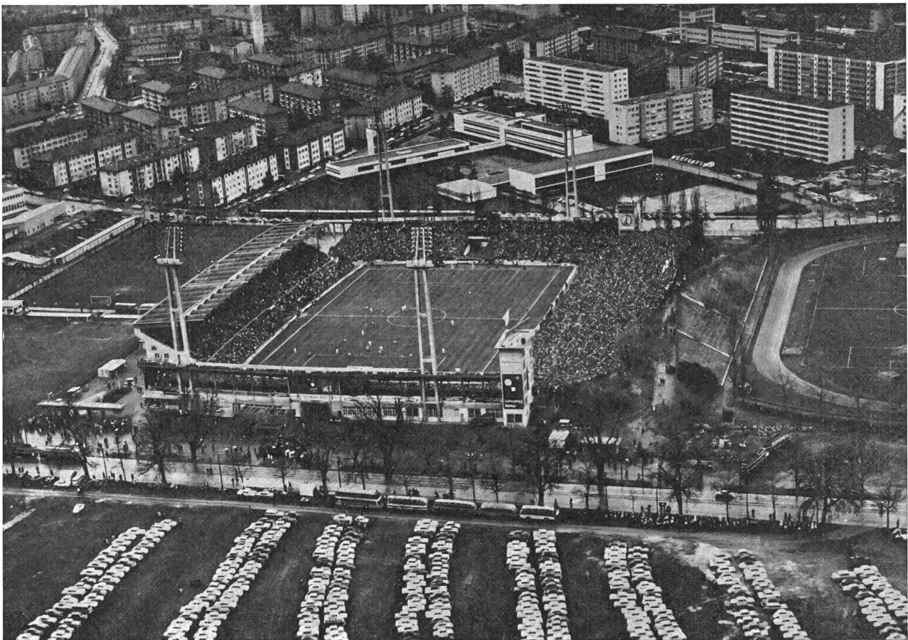
Stadion Wankdorf Bern (beim Cup-Final 1966) — Die Luftaufnahme zeigt deutlich das spezialisierte Fussballstadion sowie den Anschnitt des danebenliegenden Leichtathletikstadions, eine Anordnung, die sich bewährt hat. (Swissair-Foto)
