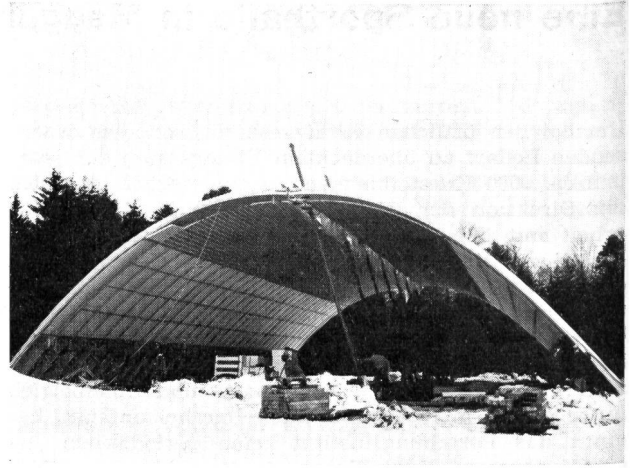
Das rechte Widerlager der aufgerichteten Dreigelenkkonstruktion wird fixiert.
