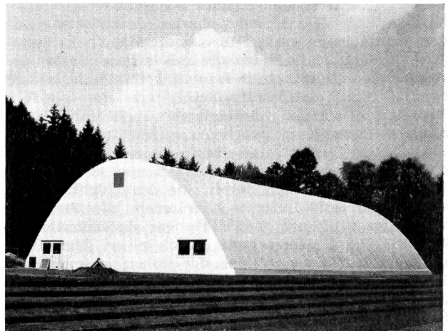
Die Stirnwände sind geschlossen, und die Halle ist für die Montage der Installationen bereit.
