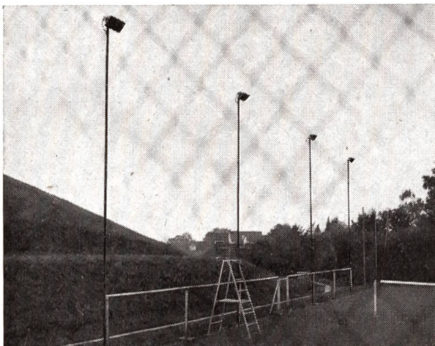
Spezialkonstruktion bei seitlichen Gittern unter 4 m Höhe.
