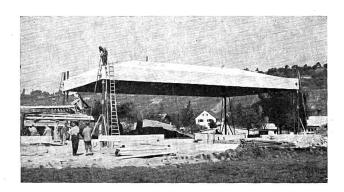
Fertig gehobenes Dach zur Abstützung an allen vier Ecken bereit. Die Säulen können vor dem Heben versetzt oder auch nachträglich angebracht werden.
