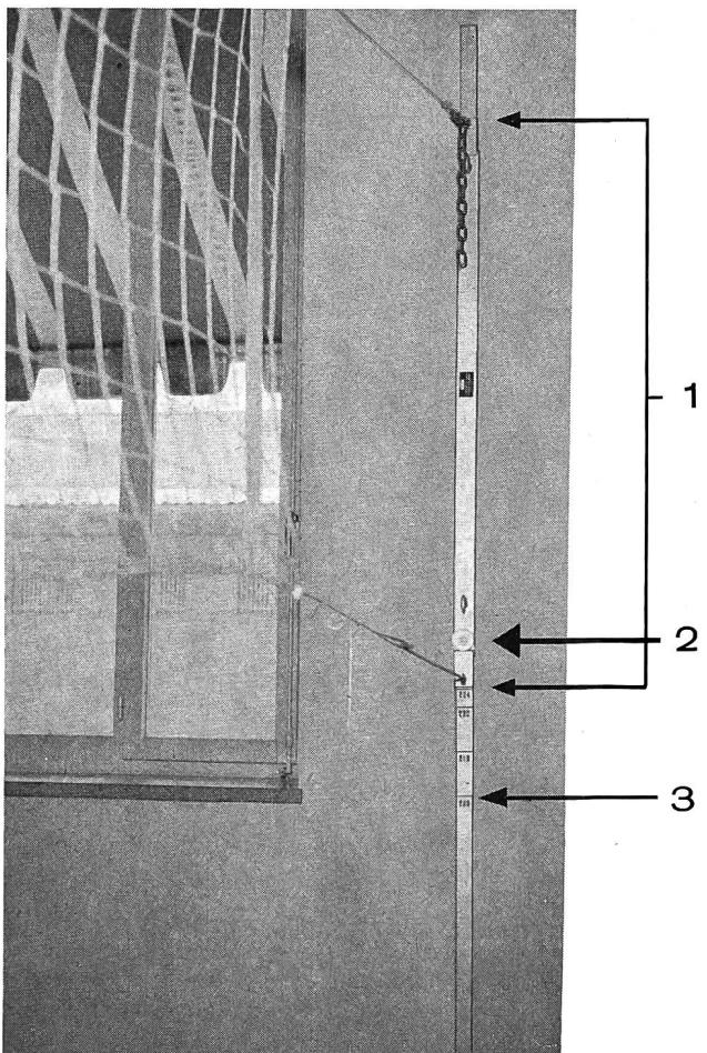
1 Beweglicher Gleitschieber mit Haken zur Netzbefestigung, auf der Gegenseite oben mit Rolle und Kettenarretierung
