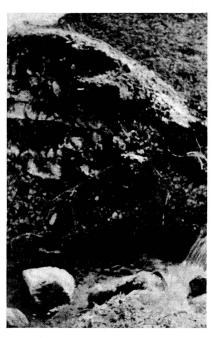
Fig. 46. — La route romaine au Pont Porret (Fresens) ; A, tablier ; B, mur de soutènement à l'endroit marqué en A par les flèches simples ; C, blocs éboulés à l'endroit marqué en A par les flèches doubles.
