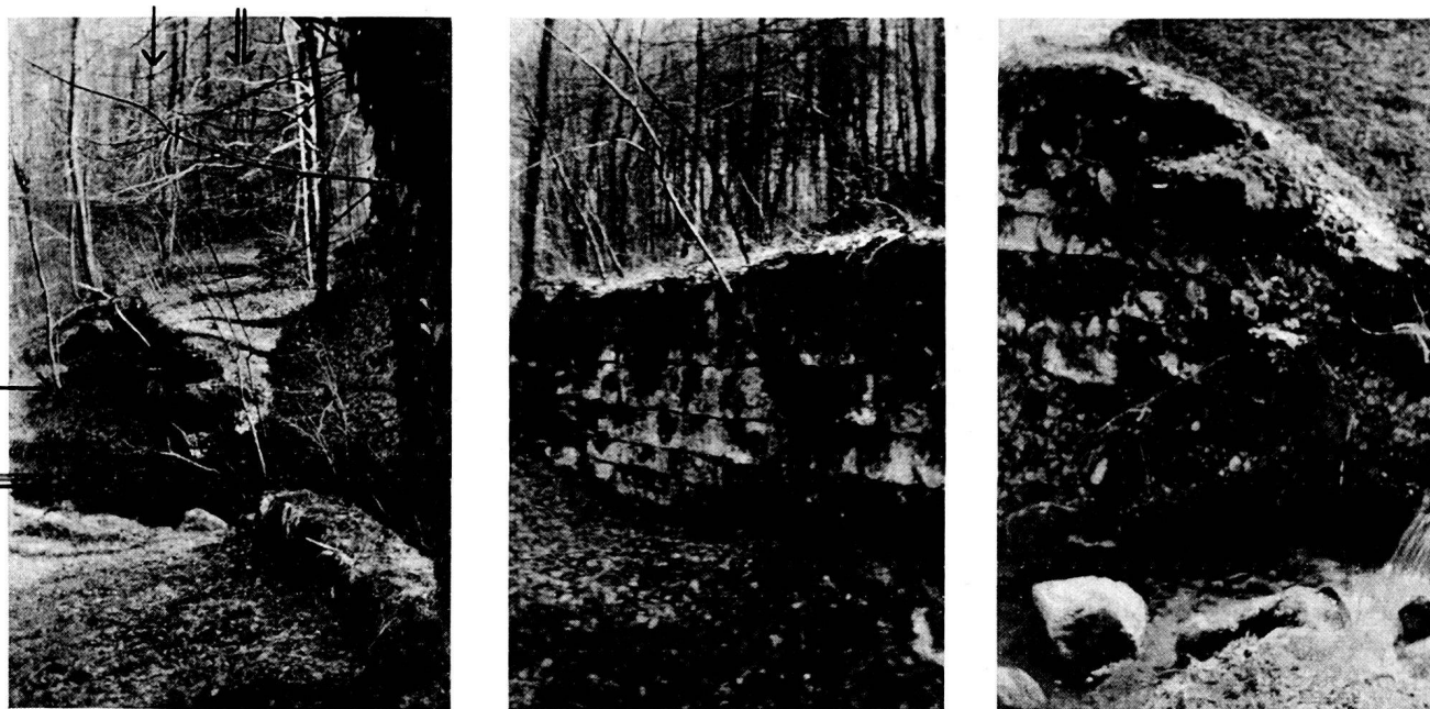
Fig. 46. — La route romaine au Pont Porret (Fresens) ; A, tablier ; B, mur de soutènement à l'endroit marqué en A par les flèches simples ; C, blocs éboulés à l'endroit marqué en A par les flèches doubles.
