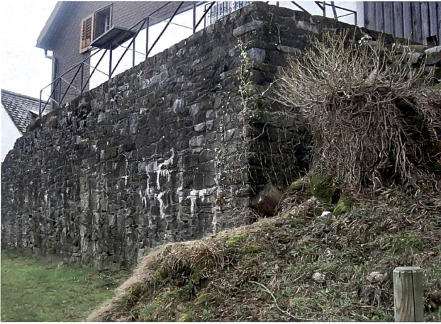
Restmauerwerk des römischen Wachturms Voremwald Filzbach (Foto: Stefan Paradowski).
