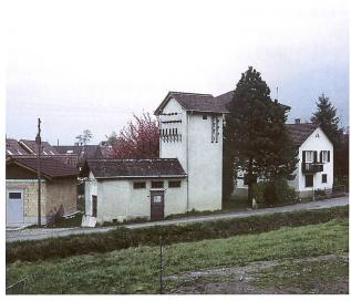
Die Trafostation Dorf am Rütibach musste zwischen 1911 und 1994 stetig dem Strombedarf der Bevölkerung angepasst werden. Usprünglich ein Einzeltürmchen, um 1927 durch einen ersten Anbau erweitert, wurde ihm 1953 ein etwas dickerer Turm angefügt. Dieser Komplex bestand bis 1994 (fotografiert vor dem Abbruch). Rechts neben dem Nadelbaum findet sich das damalige Haus Bernardi und die Rütibachbrücke zum Burgschulhaus.
