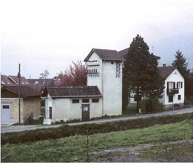
Die Trafostation Dorf am Rütibach musste zwischen 1911 und 1994 stetig dem Strombedarf der Bevölkerung angepasst werden. Ursprünglich ein Einzeltürmchen, um 1927 durch einen ersten Anbau erweitert, wurde ihm 1953 ein etwas dickerer Turm angefügt. Dieser Komplex bestand bis 1994 (fotografiert vor dem Abbruch). Rechts neben dem Nadelbaum findet sich das damalige Haus Bernardi und die Rütibachbrücke zum Burgschulhaus.
