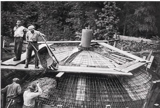
Betonierung der ersten Kuppel des Reservoirs Giselrüti durch die Firma Hans Schnellmann aus Wangen (Quelle: Glaus, Beat: AGR. Verzeichnis ihres alten Archivs. Vervielfältigt, Zürich 2003).
