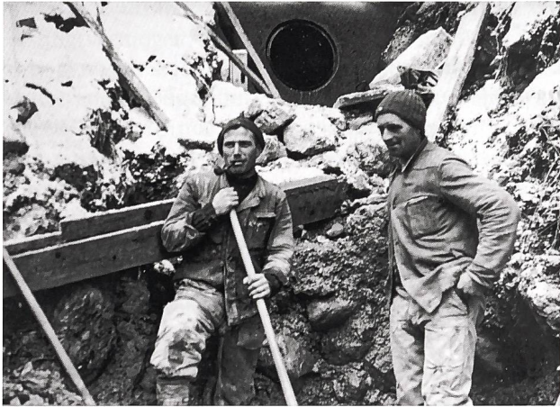
«In Schnee und Kälte sind die Arbeiter stolz und vergnügt ob der wohl gelungenen Arbeit an der Quellfassung»: Die im Winter gefasste Quelle 2, fotografiert im Februar 1950 von Kaspar Reumer (Quelle: Glaus, Beat: AGR. Verzeichnis ihres alten Archivs. Vervielfältigt, Zürich 2003).
