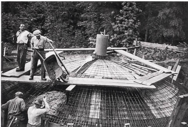
Betonierung der ersten Kuppel des Reservoirs Giselrütli durch die Firma Hans Schnellmann aus Wangen (Quelle: Glaus, Beat: AGR. Verzeichnis ihres alten Archivs. Vervielfältigt, Zürich 2003).
