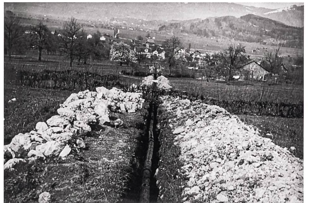
Eine steinige Gegend für den Leitungsgraben beim unteren Rüteli in Richtung Gasthof «Krone». Dieses Gebiet befindet sich an der Ecke Allmeindlistrasse/Kantonsstrasse (Quelle: Glaus, Beat: AGR. Verzeichnis ihres alten Archivs. Vervielfältigt, Zürich 2003).
