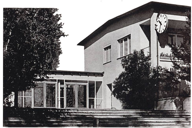
... und eine zweckmässige und moderate moderne Architektur setzt sich durch: Hermann Baur, Schulhaus im Bruderholz/Basel, 1939 (aus: Kidder Smith, Switzerland Builds, 1950).
