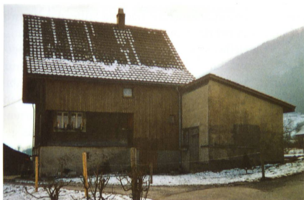
Ursprüngliche Reichenburger Metzgerei Mettler im Leh, rechts mit Schlachthaus und Laden. Metzgerei und Laden um 1920 ersetzt durch Neubau Kantonsstrasse 72, Schlachthaus bis 1964 im Gebrauch.
