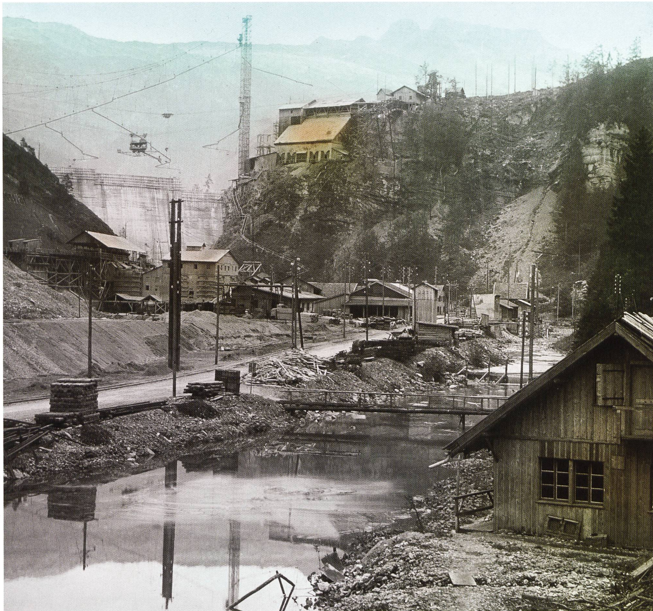
Die Arbeiten an der Staumauer Schräh schreiten zügig voran (September 1924).
