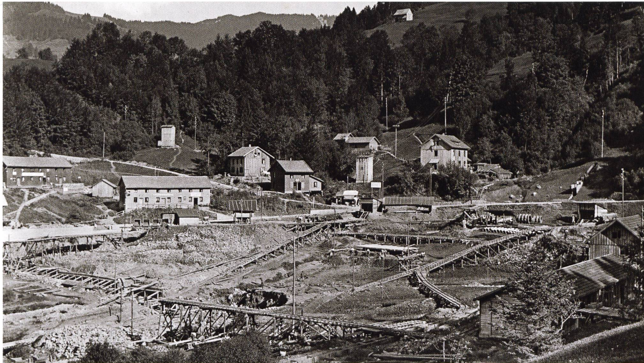
Die Aufnahme dokumentiert die Aushubarbeiten und Baupisten im Bereich der geplanten Zentrale Rempen am 1. Oktober 1923.
