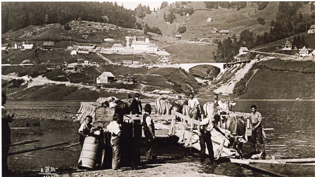
Die Letzten verlassen die Talebene: Viehtransport der Familie Züger (später in Wangen). Im Hintergrund wird an neu Innerthal gebaut. Zu erkennen ist die neu erstellte Flienglibachbrücke, ein Eisenbeton-Pionierbau von Ingenieur Robert Maillart (gesprengt 1968).
