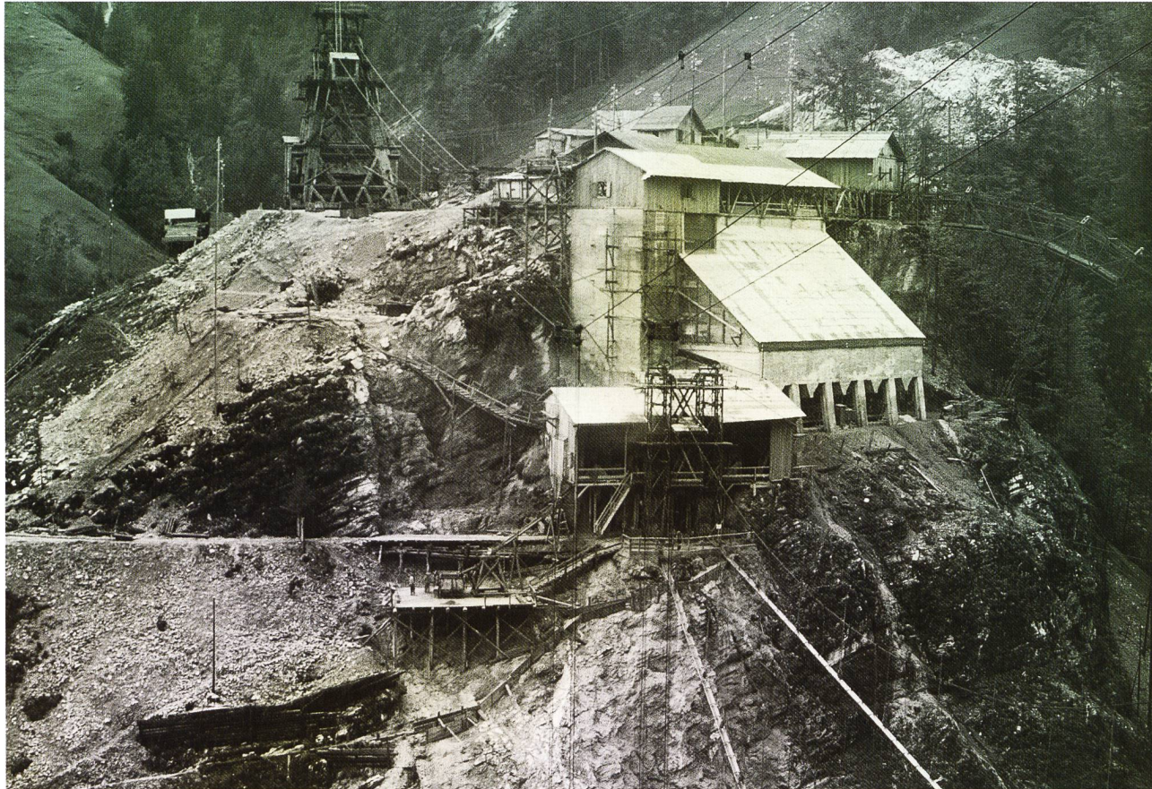
Auf dem Schrährücken entstand eine riesige Betonieranlage (1923).
