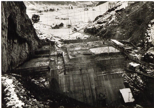
Der Grundstein für die grosse Staumauer ist gelegt, das Fundament betonierte (1923).
