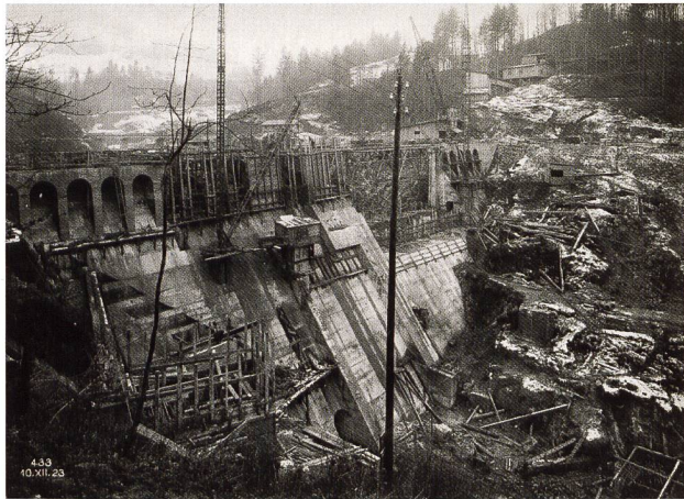
Ein Koloss im Bau: die Staumauer im Rempen während der Bauarbeiten (1923).
