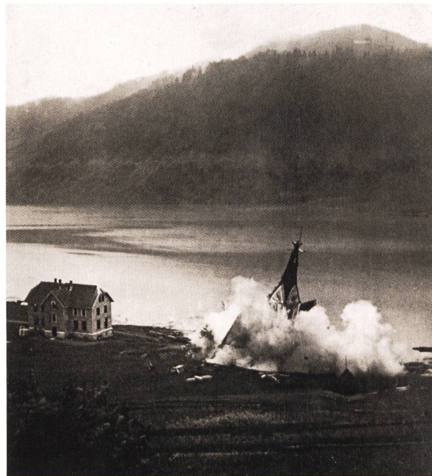
Kurz bevor das Wasser die Kirche erreicht, wird sie gesprengt.
