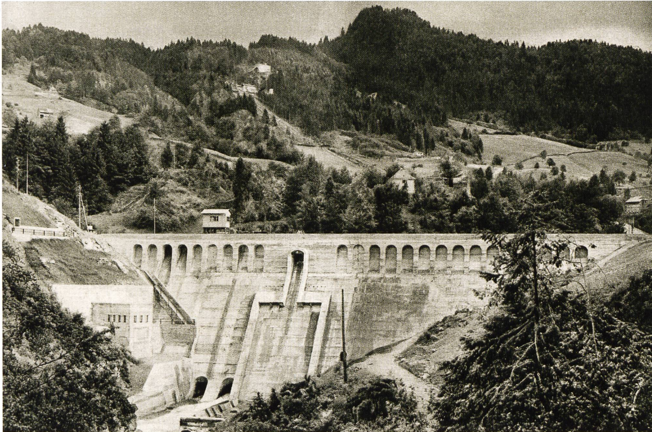
Die Staumauer Rempfen von der Luftseite her gesehen mit den Saugüberfällen, Grundablässen und dem Schieberhaus.
