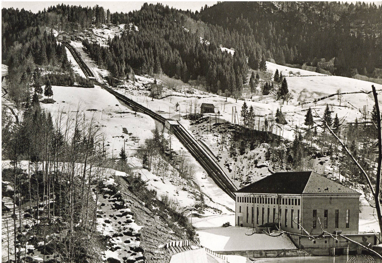
Das fertigerstellte Maschinenhaus in der Zentrale Rempen mit der imposanten Druckleitung.
