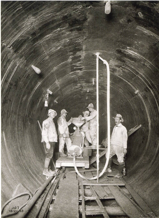
Im Druckstollen werden Zementinjektionen in den Fels eingeschossen.
