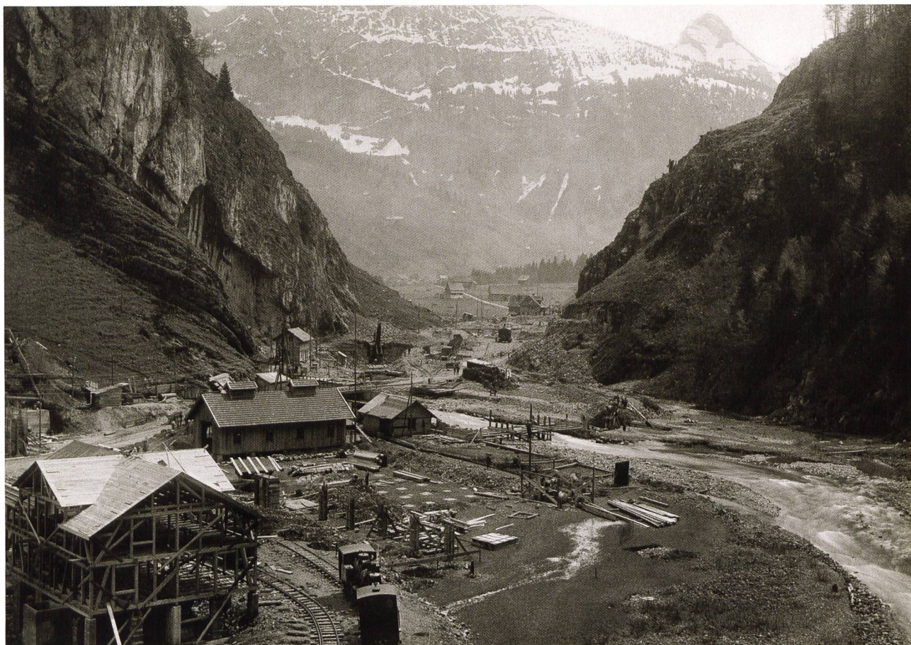
Im Schrah-Engpass wurden 1922 provisorische Baupisten und Baubaracken erstellt.
