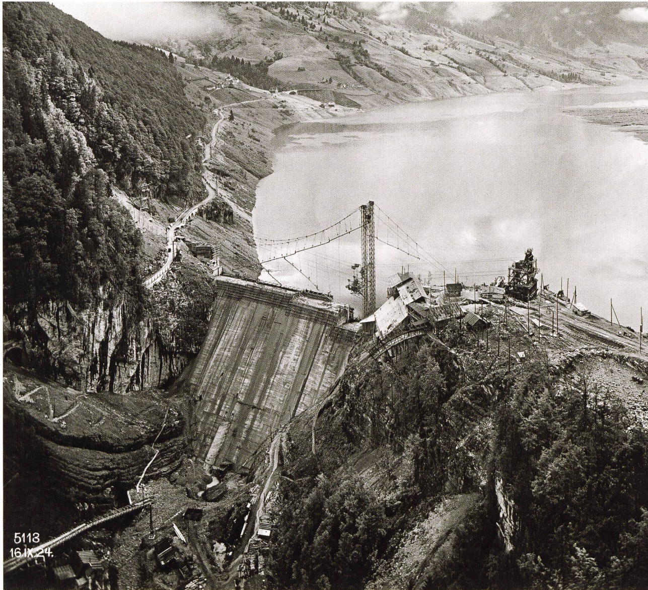
Der künstliche Abschluss des Wägitalersees: die grosse Staumauer im Schräh (September 1924). Links ist die neue, rechtsufrige Seestrass zu erkennen. Die Wassertiefe beträgt zu diesem Zeitpunkt rund 22 Meter.
