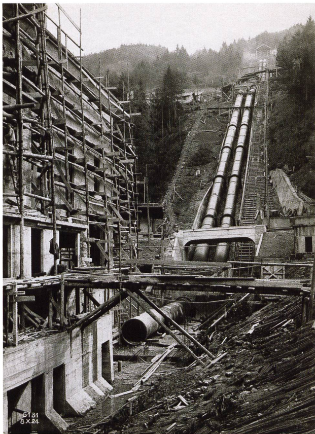
Je grösser das Gefälle, desto geballter die Wasserkraft. Verlegung der Druckstollen hin zum Maschinenhaus im Rempen (1924).
