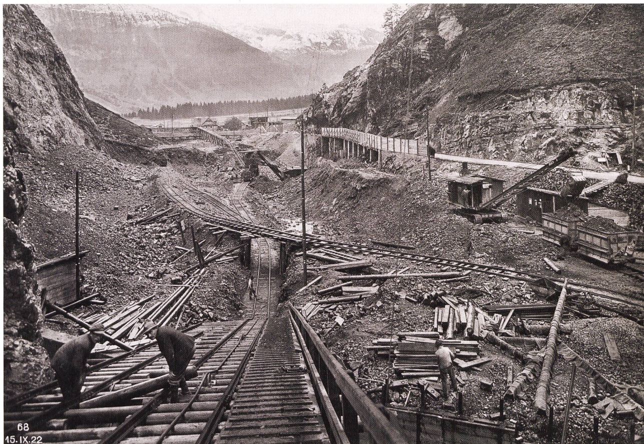
1922 wurden Transportgeleise für die Bauarbeiten an der grossen Staumauer im Schräh eingerichtet.
