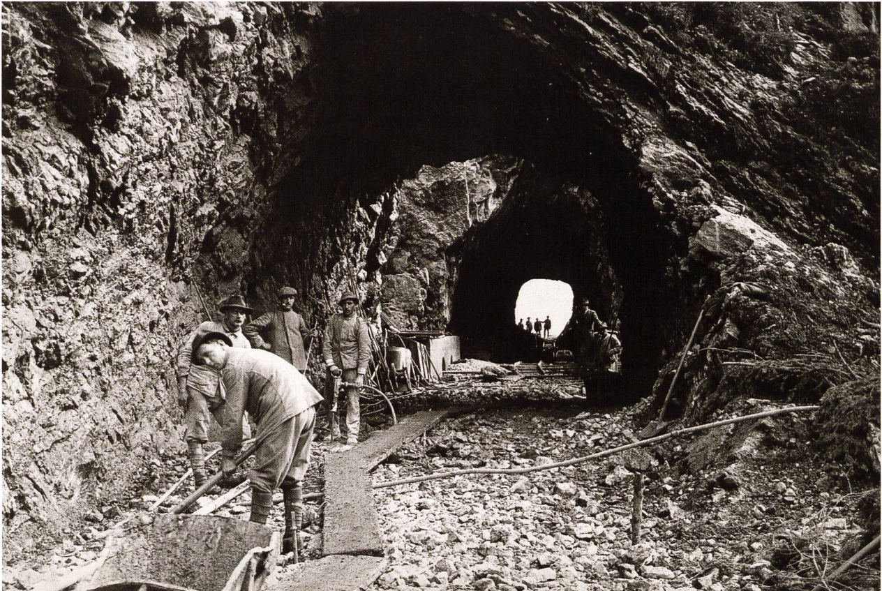
Die neue Zufahrtsstrasse nach Innerthal musste zum Teil aus dem Felsen gesprengt werden.
