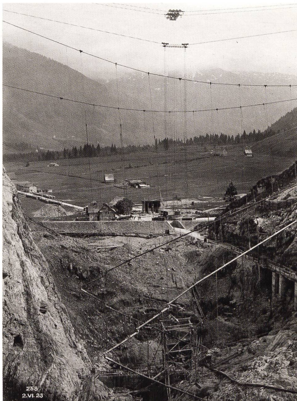
1923 wurde mit den Betonierungsarbeiten für die grosse Staumauer im Schräh begonnen.
