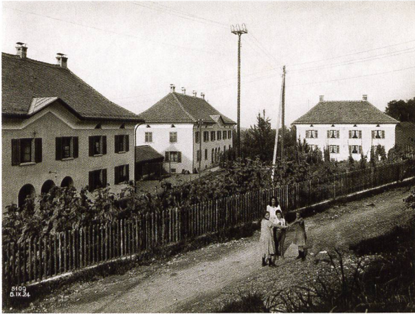
Für das Betriebspersonal musste in unmittelbarer Nähe der Zentralen Rempen und Siebnen (Bild) eine grössere Anzahl von Wohnungen erstellt werden.
