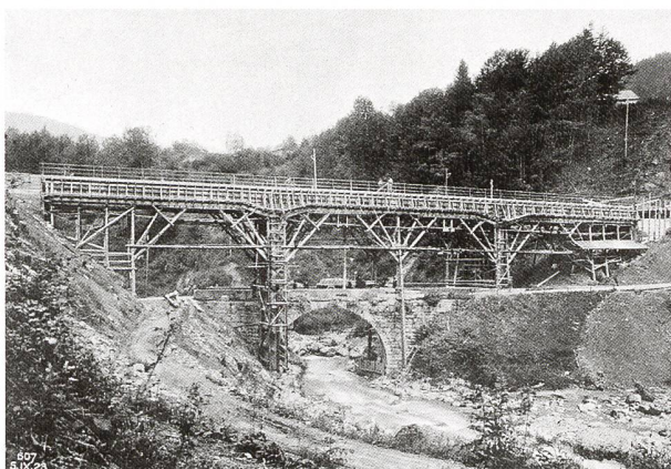
Die neue Aa-Brücke über das Rempnenbecken nimmt Gestalt an. Im Vordergrund ist noch die alte, steinerne zu erkennen.
