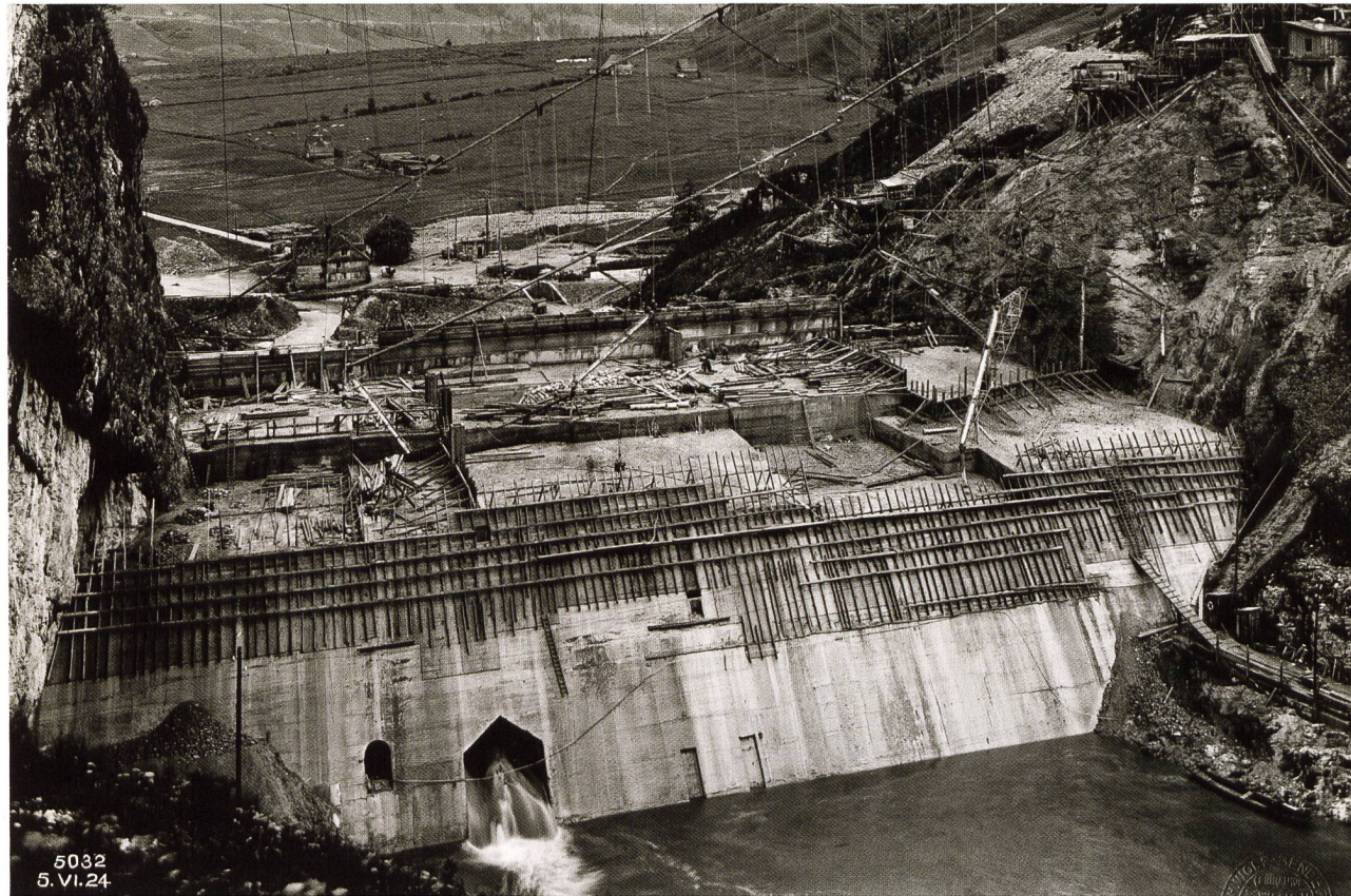
Nachdem die Basis der Mauer fertiggestellt ist, kann die Aa durch eine Schleuse mitten in der Mauer abgeleitet werden (1924).
