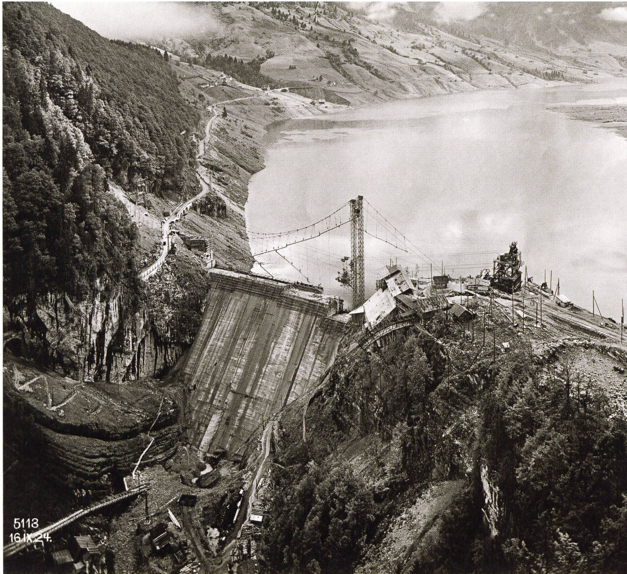
Der künstliche Abschluss des Wägitalersees: die grosse Staumauer im Schräh (September 1924). Links ist die neue, rechtsufrige Seestrasse zu erkennen. Die Wassertiefe beträgt zu diesem Zeitpunkt rund 22 Meter.
