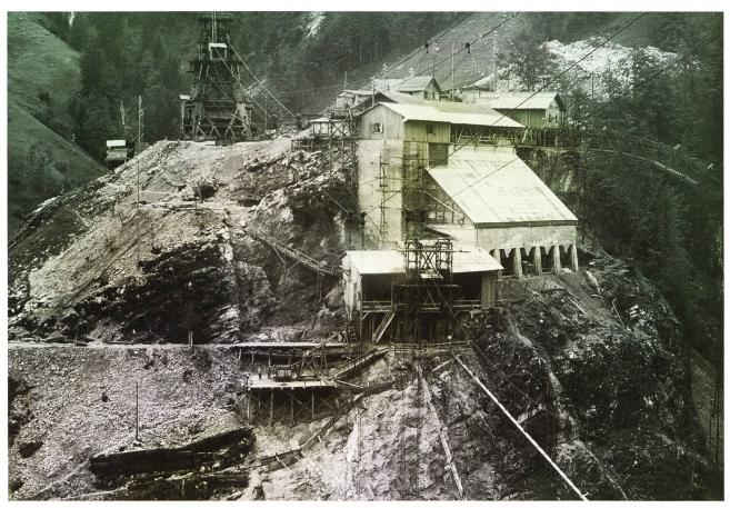
Auf dem Schrährücken entstand eine riesige Betonieranlage (1923).
