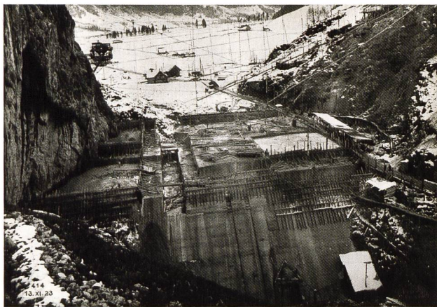
Der Grundstein für die grosse Staumauer ist gelegt, das Fundament betoniert (1923).
