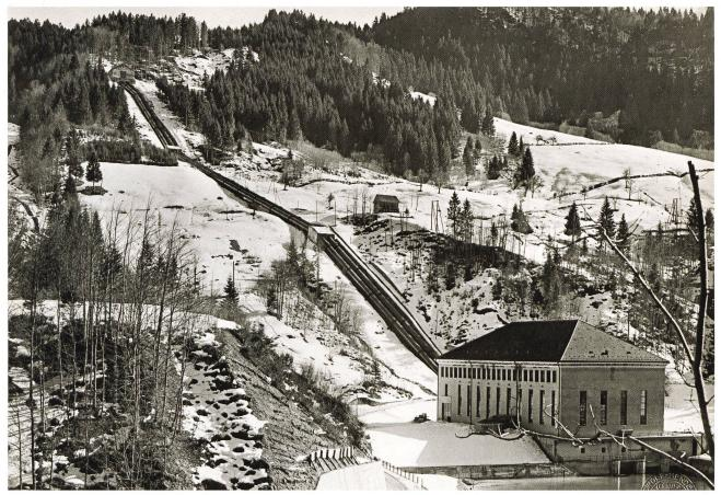
Das fertigerstellte Maschinenhaus in der Zentrale Rempen mit der imposanten Druckleitung.
