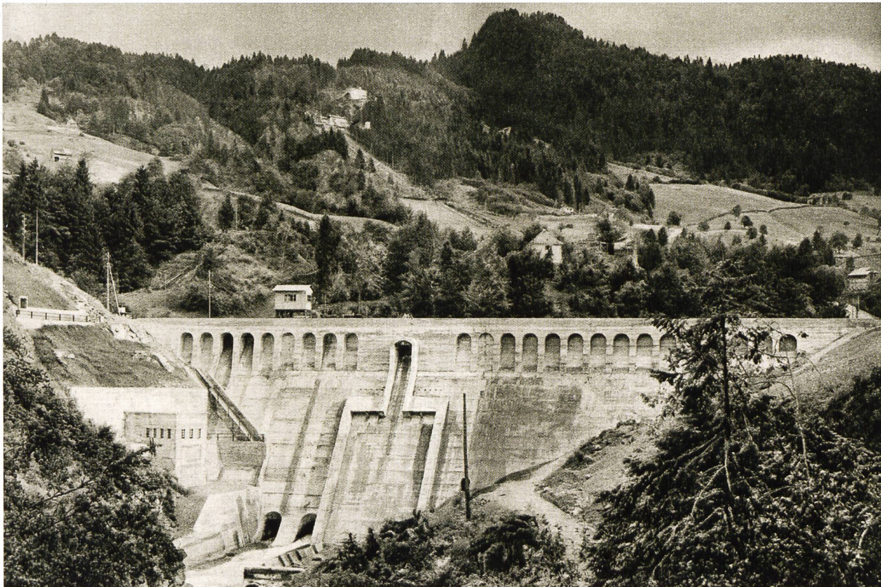
Die Staumauer Rempen von der Luftseite her gesehen mit den Saugüberfällen, Grundablässen und dem Schieberhaus.
