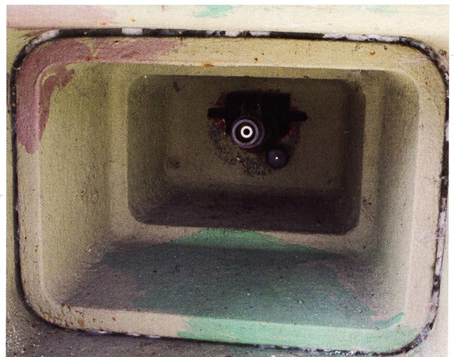
Abb. 45 Lmg-Scharte des Standes E von aussen. Unten rechts der Aufsatz zur Stabilisierung der Waffe.
