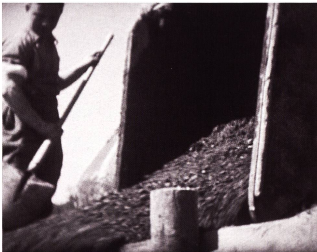
Abb. 31 Die Armee hat den Bau des Werks Gry nau begonnen, zivile Firmen führten die Arbeiten zu Ende. Im Bild ein Soldat beim Betonieren von Ständen im Holeneich bei Tuggen. 1
