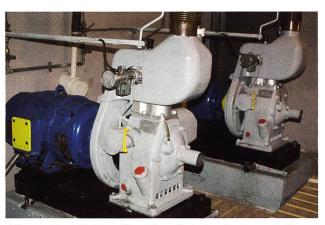
Abb. 4 Das Werk verfügte über drei eingebaute, petrolbetriebene Notstromaggregate.
