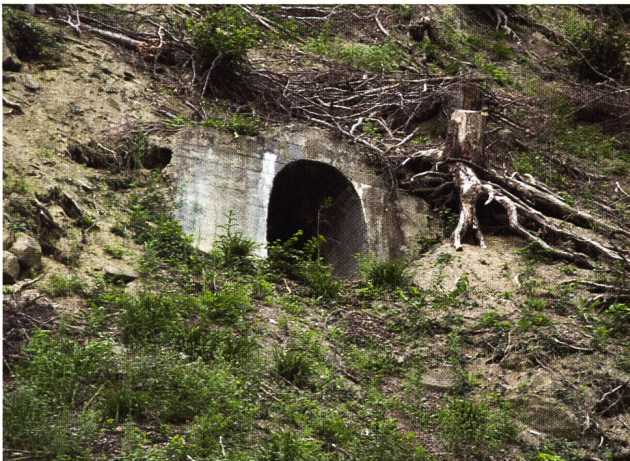
Abb. 16 Das Stollenende bei der Funknische
