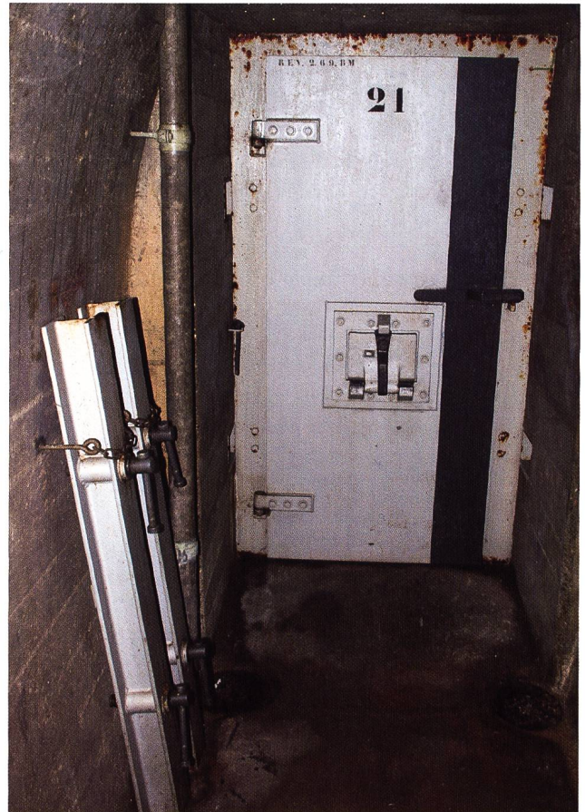
Abb. 25 Panzertür im Stollen. Links sind die Stahlbalken zu erkennen, mit denen die Türe verstärkt werden kann.
