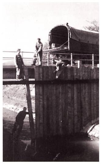
Abb. 21 Nadelwehr in der Linthebene<sup>24</sup>
