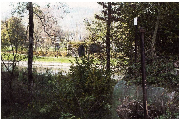
Abb. 19 Bunker 6914 (Stand 27) auf dem Süduferdamm des Linthkanals. Vorne rechts ist das Dach des Standes Mg 01 zu erkennen.
