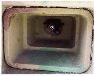
Abb. 45 Lmg-Scharte des Standes E von aussen. Unten rechts der Aufsatz zur Stabilisierung der Waffe.
