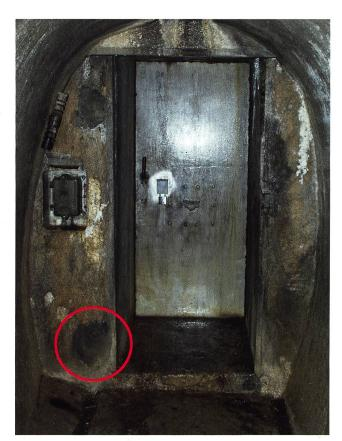
Abb. 49 Türe des Notausgangs geöffnet, rot eingekreist der zubetonierte HG-Auswurf.
