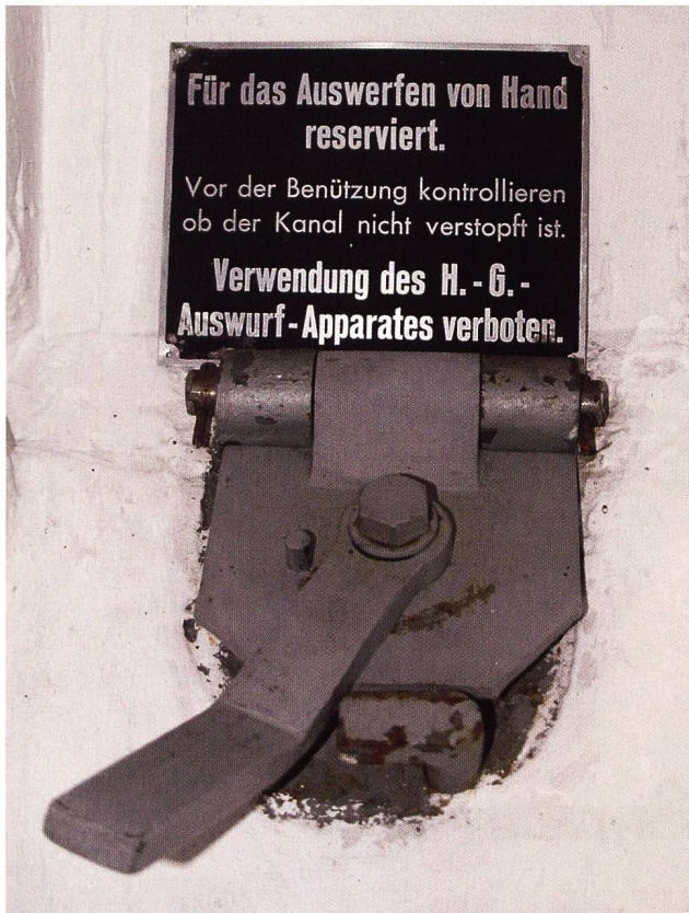
Abb. 48 Deckel der HG-Auswurföffnung im Stand E
