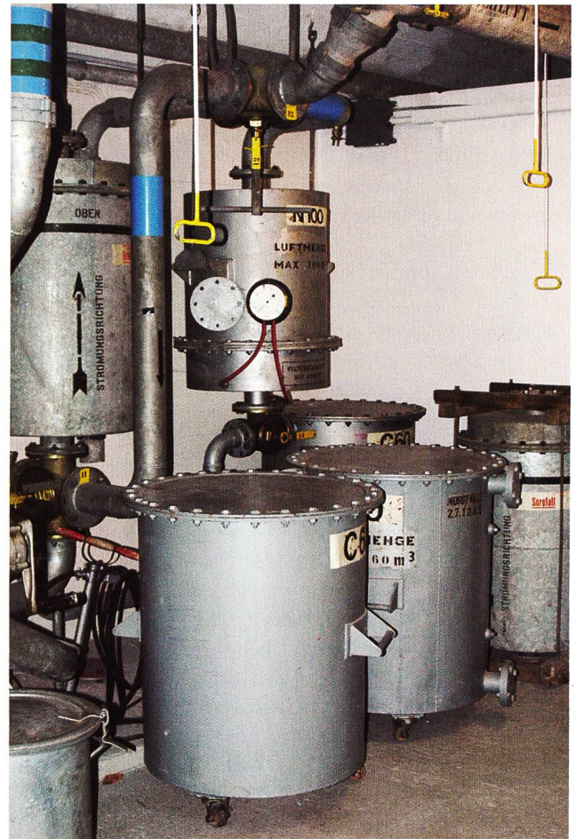
Abb. 62 Die Luftfilteranlage für das gesamte Werk ist bei der Kaverne. Vorne auf Rollen die eigentlichen Filter.
