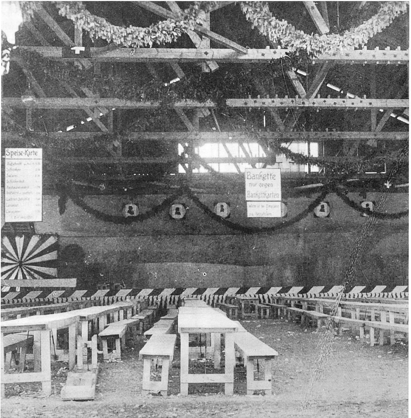
Blick in die Festhütte in der Magazinhalle des Baugeschäftes von Benedikt Kälin. Aufnahme am Sonntag, 17. Juni 1928.
