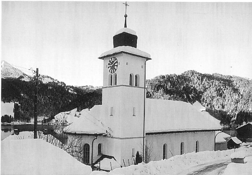
Abbildung 12: Nordfassade der neuen Pfarrkirche St. Katharina, Dezember 1996.
