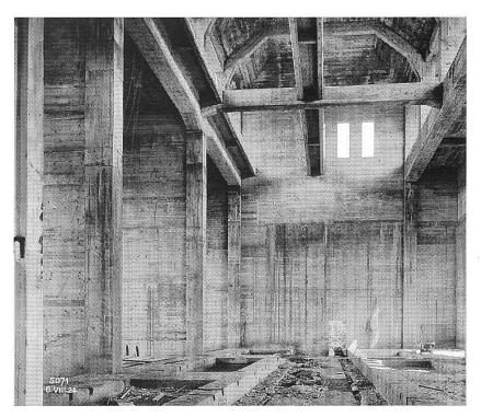
Betonkonstruktion des Schalthauses im Rohbau (August 1924, AKW).
