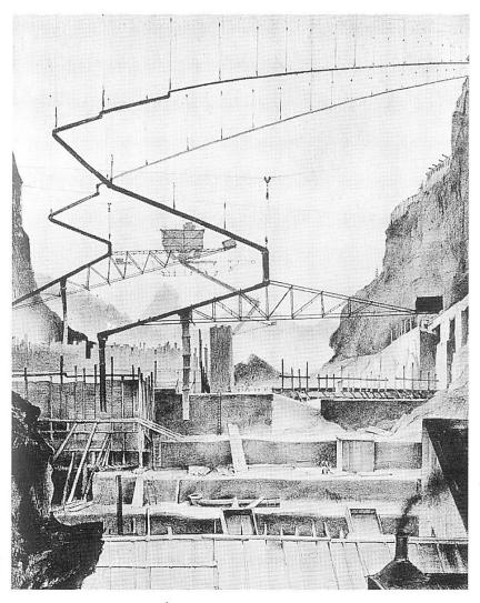
Bauinstallationen für die Schrähmauer auf einer zeitgenössischen Lithografie, mit frei beweglich aufgehängten Betonierrinnen und Betonierplattform an Kabelkran (gegen Ende 1924, AKW).
