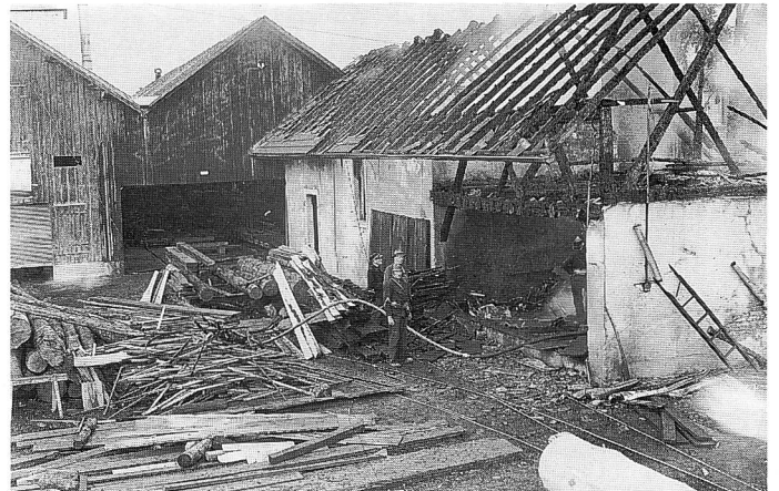
Brand der Trocknungsanlage der Sägerei Vogt, 1944.
