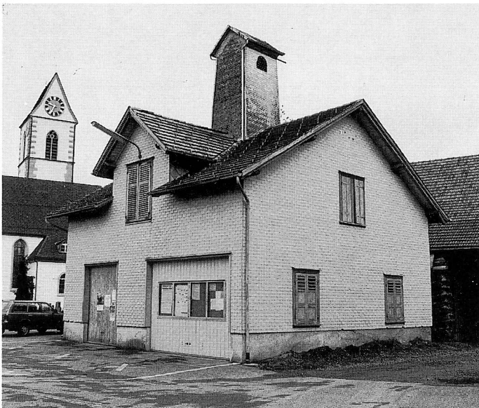
Das erste Spritzenhaus aus den frühen 1920er Jahren.
