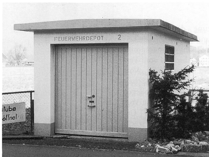
Feuerdepot 2, oberer Kreis, Siebnen.
