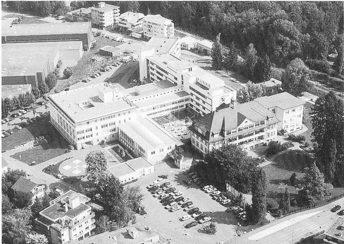
Der städtische Komplex nach dem Abschluss der Arbeiten im Herbst 1993. Im Vergleich zur Flugaufnahme von 1920 scharen sich die Bauten um den Altbau vom 1915: Links liegt der neuen Behandlungstrakt mit Operationssälen, Röntgen, Notfallstation, Aufwachraum und Überwachungsstation. Oben hängt sich abgewinkelt der neue Betten trakt an den Bau von 1967. Vorne liegt der Helilandeplatz mit dem Gebäude der Cafeteria und der Verwaltung. In der Mitte liegen der Zwischentrakt und das Spital von 1967, und der Anbau von 1954 rechts am Altbau ist deutlich erkennbar. (Foto Spital)
