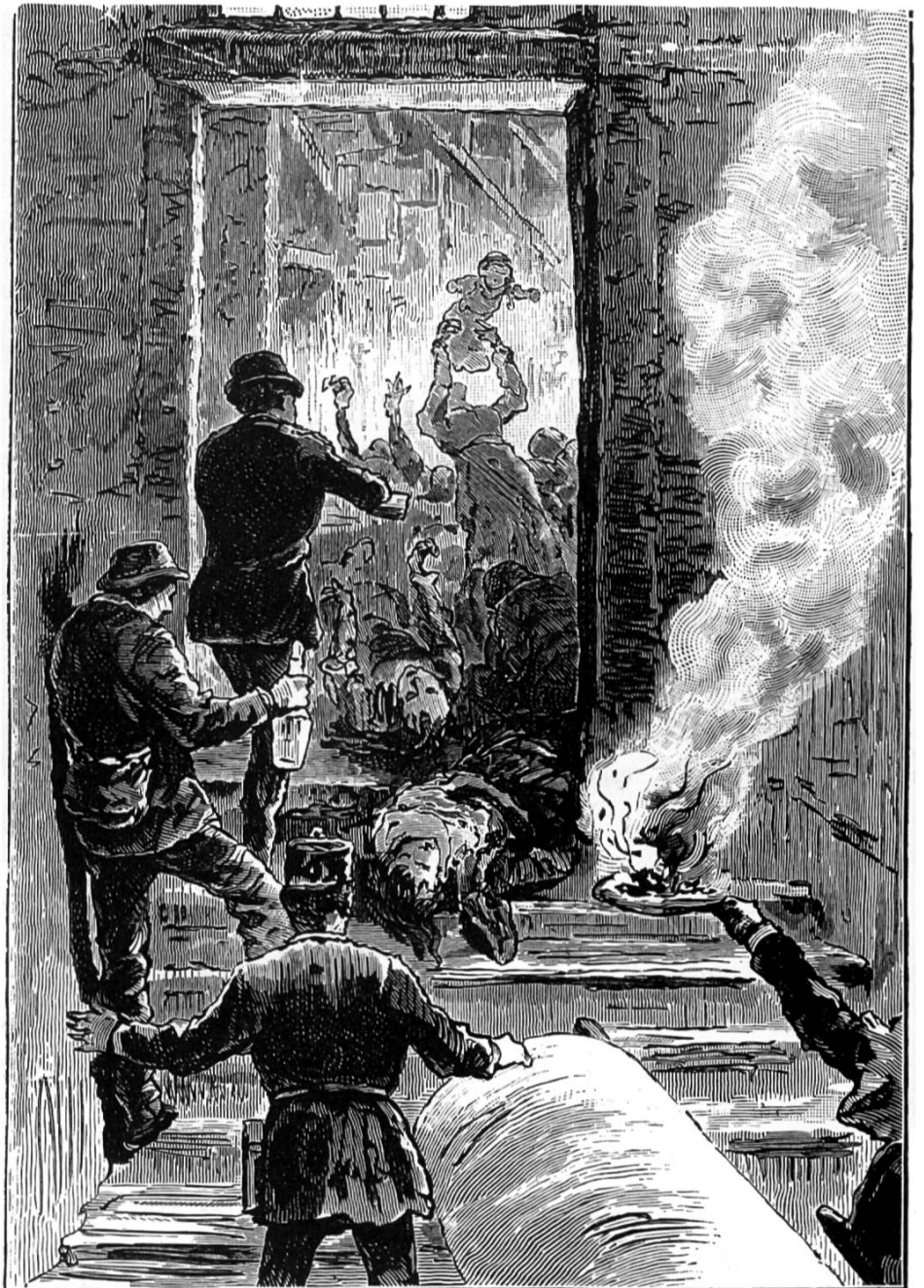
Desinfizieren eines Hauseingangs, Bildarchiv des Medizinhistorischen Instituts der Universität Zürich.
