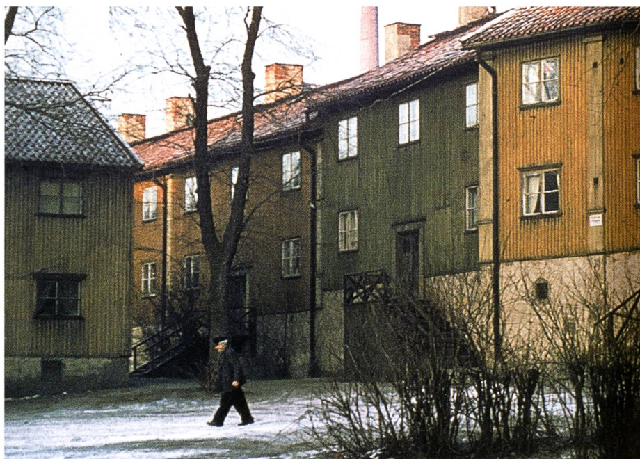
Erik Gunnar Asplund, quartier Stativet och Tumstocken, photographie de 1964.
