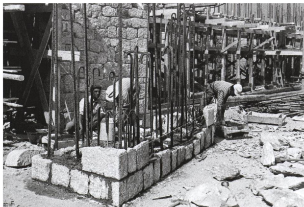
Giovanni Michelucci, l'église de l'Autoroute, photographie du chantier.
