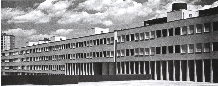
Aldo Rossi, logements à coursives dans l'unité d'habitation Monte Amiata à Milan, vue de l'extérieur.
