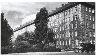
L'édifice, entièrement occupé par quelque 290 logements répartis sur cinq étages et distribués par vingt-neuf cages d'escalier doubles, présente une profondeur constante d'environ dix mètres. Les planchers sont portés par les murs de façade et par une épine murale située exactement en leur milieu.
