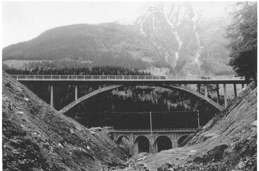
Pont sur le Laxgraben (Lax), route de la Furka (1941-1942). Photographie prise peu après l'achèvement du pont (fonds d'archives Alexandre Sarrasin, EPFL-ACM).
