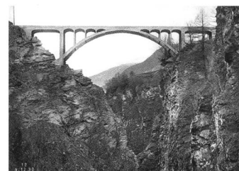
Richard Coray: cintre du pont de Salginatobel entre Schiers et Schuders dans les Grisons (1929/1930). Tiré de Gerüst- und Seilriesenbauer Richard Coray von Trins, op. cit.
