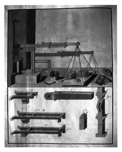
Dessin d'une machine pour le calcul de résistance des matériaux (in Description de la Machine cy jointe servant a connoitre la force des pierres, manuscrit, Ecole nationale des Ponts et Chaussées, Paris, Ms 20).
