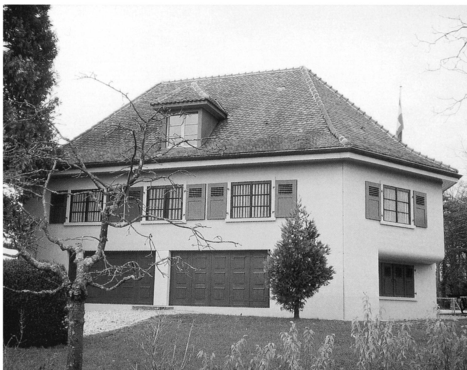
“Villa rose” après sa rénovation, novembre 1999.
