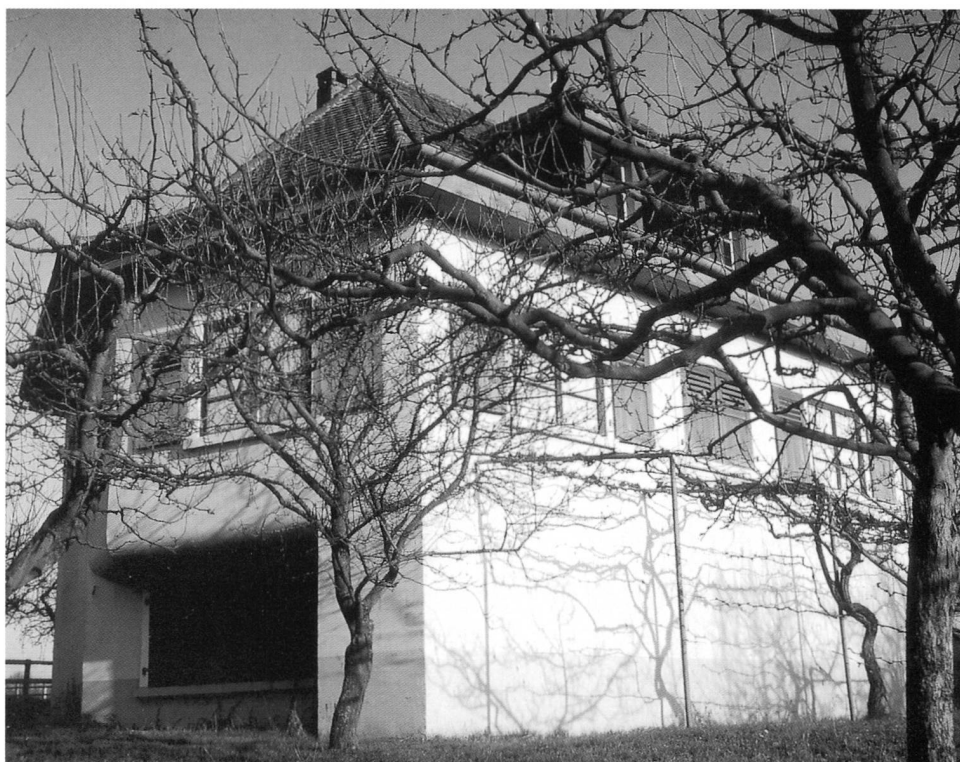
“Villa bleue” après sa rénovation, janvier 1998.
