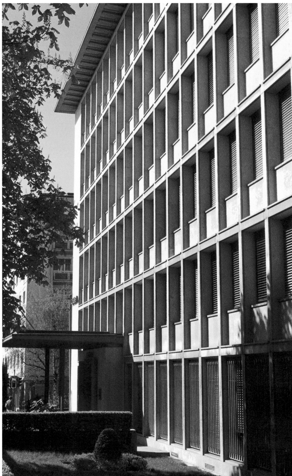
Vue de la façade principale sur Rumine, permettant d'en visualiser le caractère répétitif et le relief élégant. Seul élément en saillie, le portique d'entrée se signale comme le repère principal d'un rez-de-chaussée faiblement différencié (photo E. Rey, 1999).
