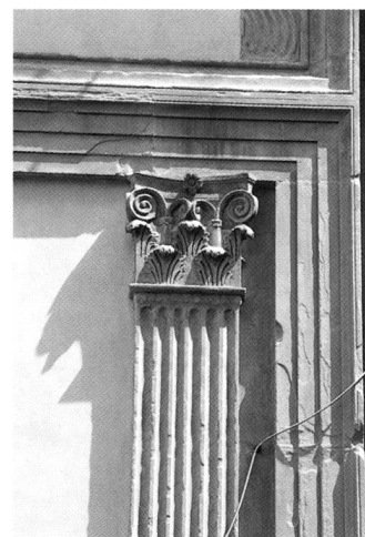
Ci-dessus, Hôpital des Innocents, Florence. Décor construit par Francesco della Luna montrant une architrave « qui se plie vers le bas », détail jugé erroné par Filippo Brunelleschi.
