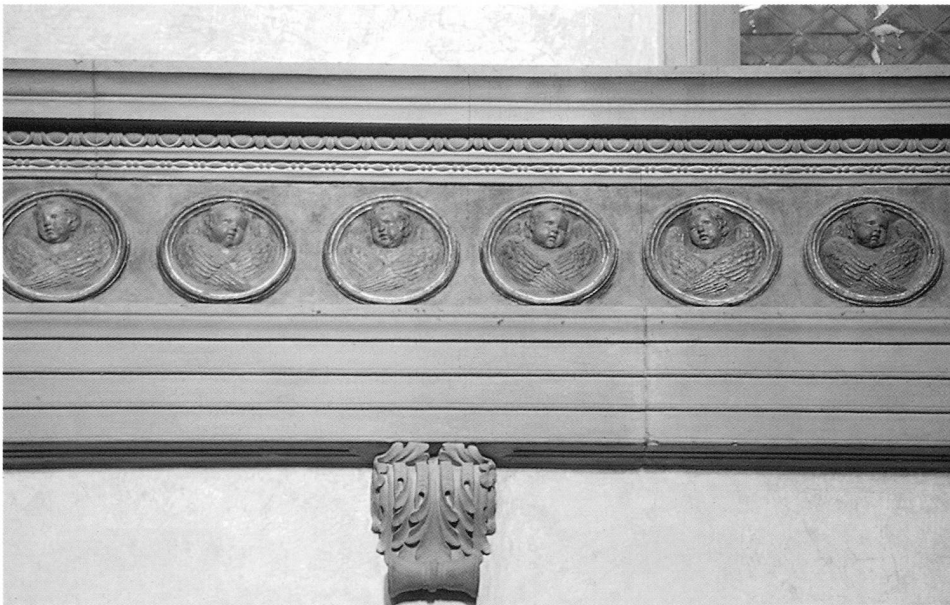
Sacristie de San Lorenzo, emplacement "irrégulier" de la console par rapport au joint de l'architrave et à l'axe de la fenêtre.
