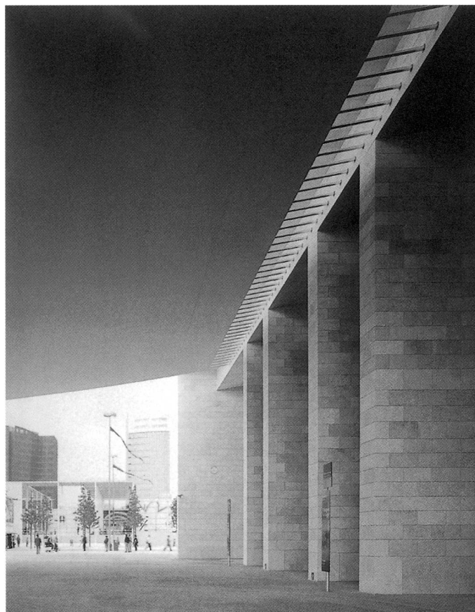
A droite, l'ancrage du voile et le joint lumière (Photo Philippe Meier).
