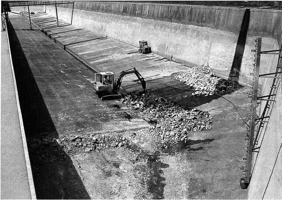
Rénovation du fond du bassin de compensation.
