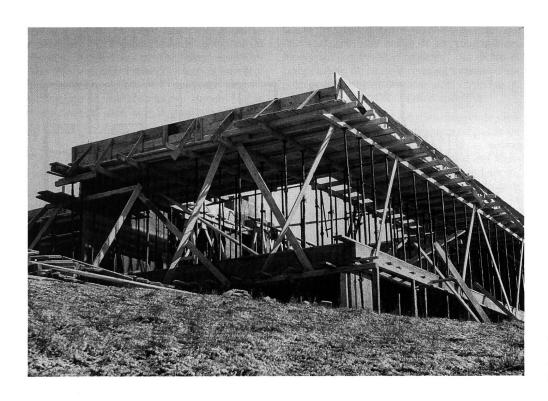
30 novembre 1956. Les murs de brique du sous-sol sont montés, la dalle du rezde-chaussée est coulée et le coffrage pour la dalle de toiture est en place.
