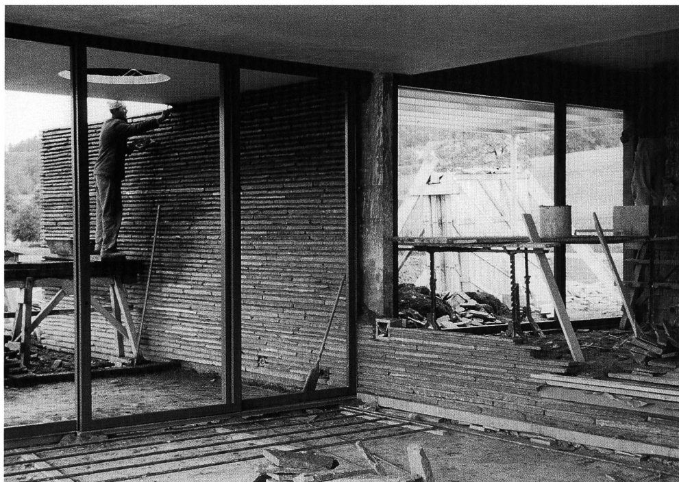
4 juin 1957. Montage du mur en pierre naturelle – granit du Tessin – qui intègre la cheminée tout en se dépliant en longueur, créant une relation entre l'intérieur et l'extérieur.
