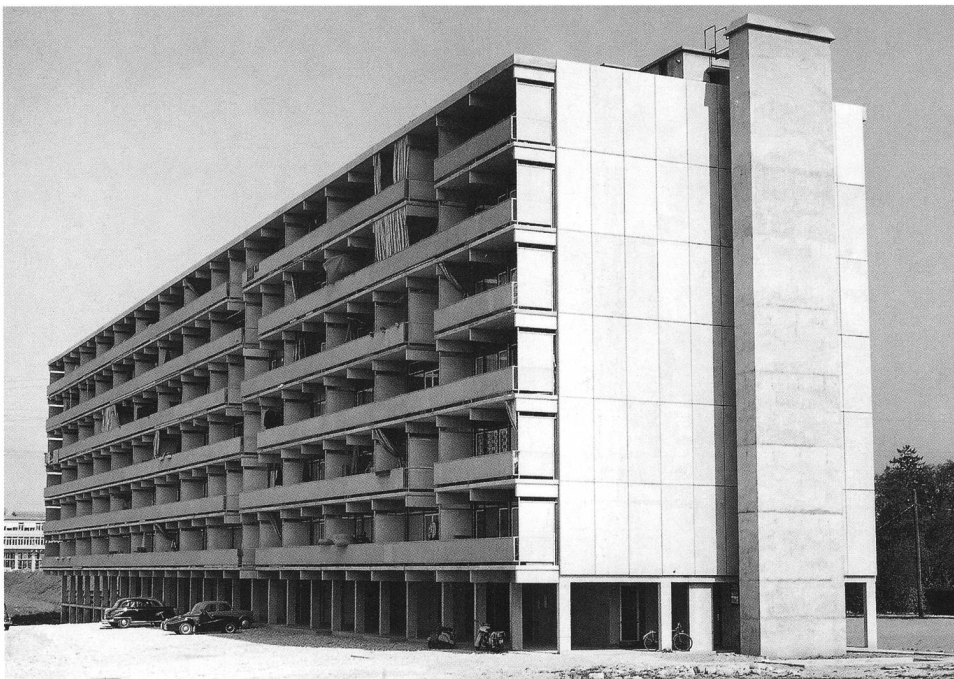
François Maurice, Jean-Pierre Dom et Jean Duret, immeuble locatif SW 3 (1959-1960) à Genève, vue du chantier (le montage des pièces préfabriquées se fait de façon linéaire par la grue) et vue des cadres étayés et des dalles préfabriquées. Vue de la façade sud-ouest.
