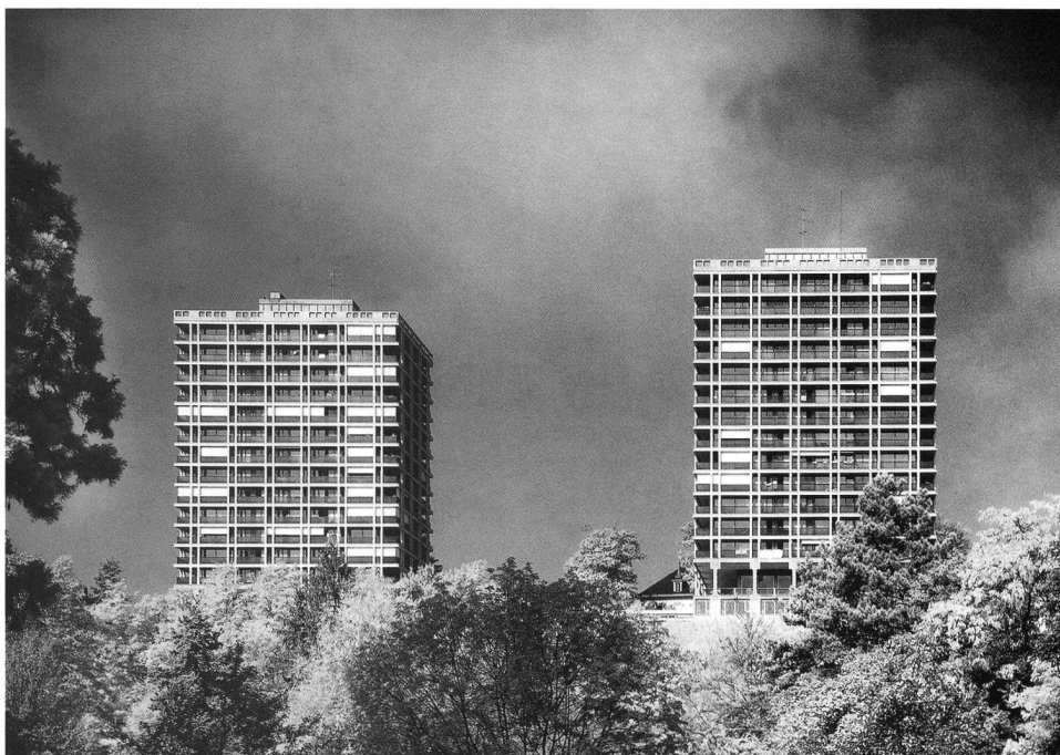
Jean-Marc Lamunière, les Tours de Lancy (1960-1964) à Genève, vue des deux tours construites. Photo Jean Pierre Flury. Doc. archives Jean-Marc Lamunière.
