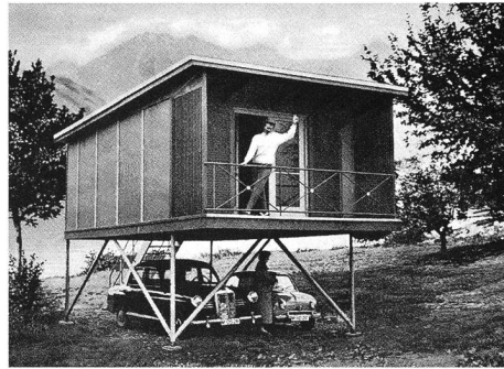
Maisons de Weekend préfabriquées, 1959. Lutz & Söhne, Munich. (D'après Mittag 1959.)
