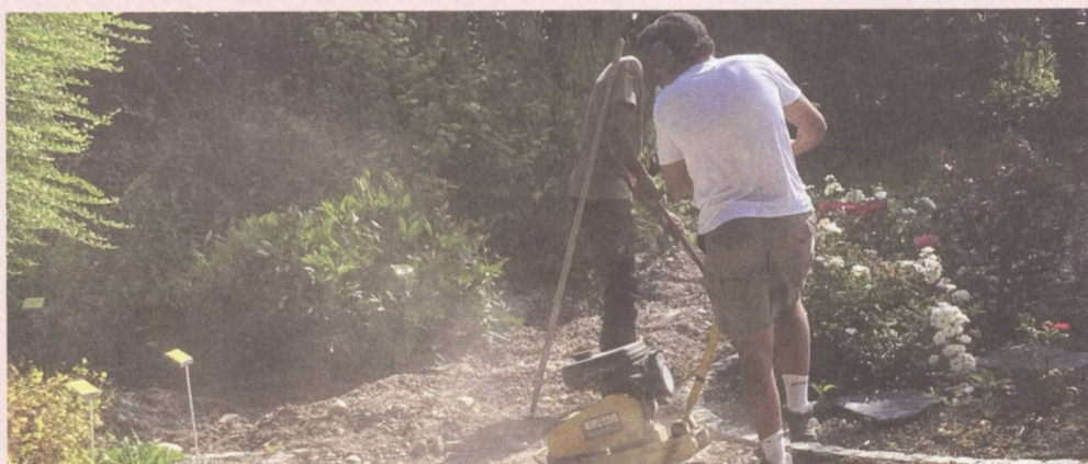
Verteilen und verdichten
