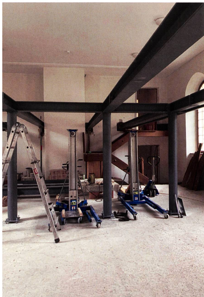
Die Stahlträger für die Zwischenböden.
