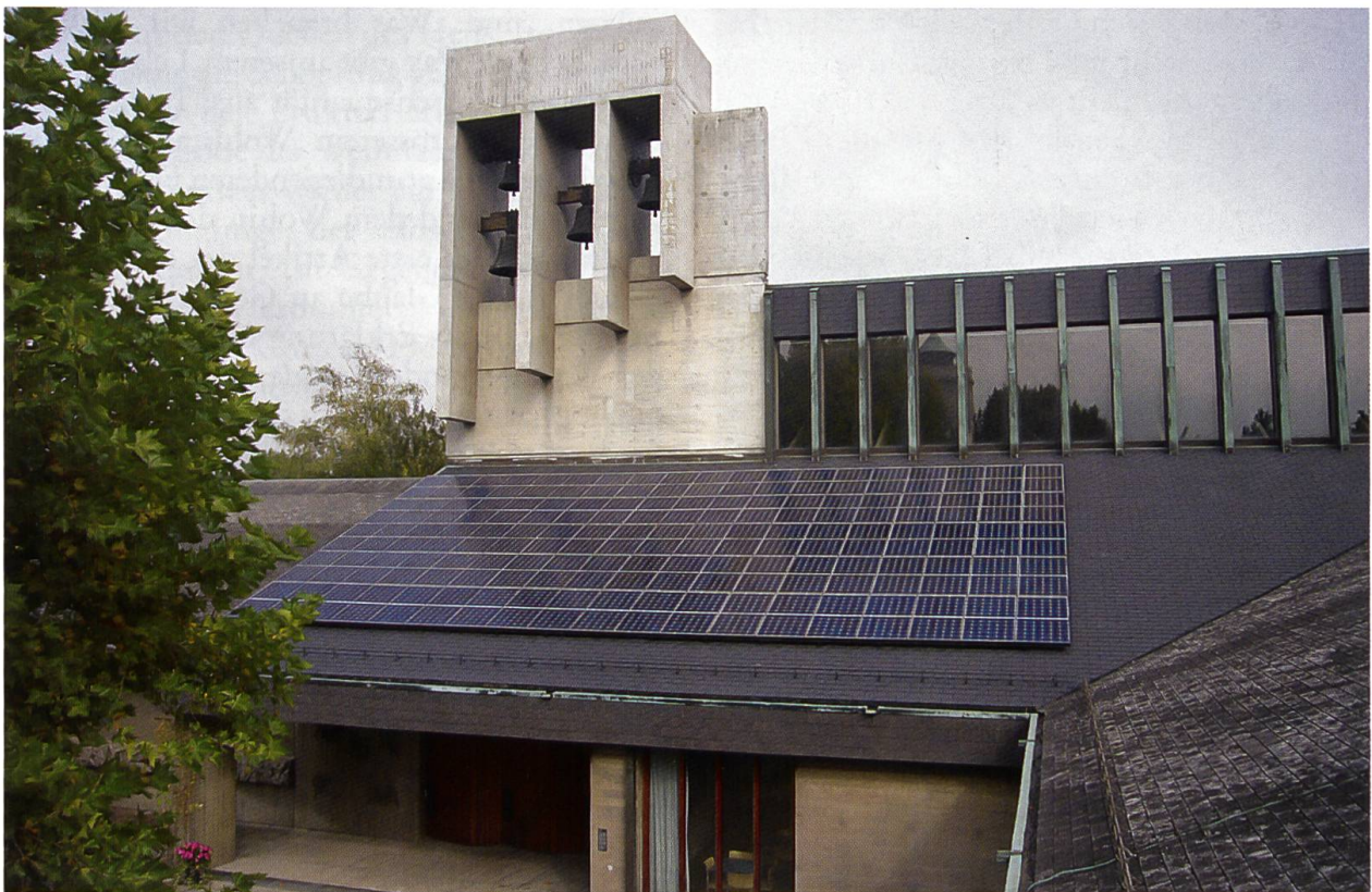
Mit gutem Beispiel voran: Auf der Dachfläche der evangelisch-reformierten Tituskirche auf dem Bruderholz in Basel wird schon seit 1990 Solarstrom produziert.
