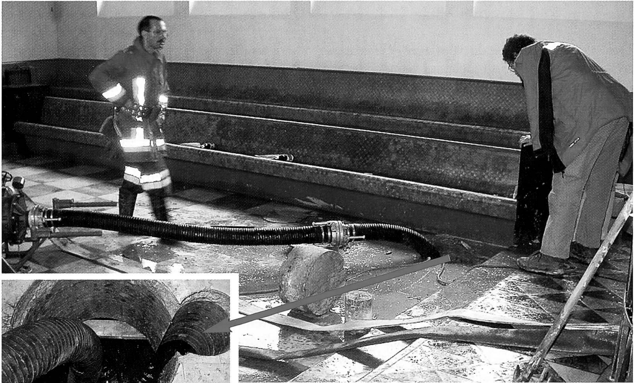
In den Boden des Kapitelsaals musste ein Loch gebohrt werden, damit das Wasser aus dem Kulturgüterschutzraum abgepumpt werden konnte.
