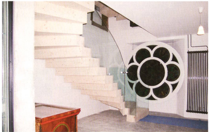
Das ausgehöhlte Treppenhaus ... Die neue Treppe (Erdgeschoss)...
