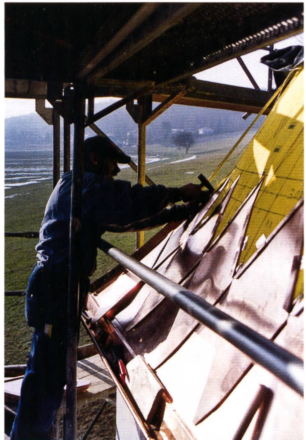
Die St. Anna-Kapelle wird neu eingedeckt (2003): Die in Rautenform zugeschnittenen Kupferschindeln werden montiert.
